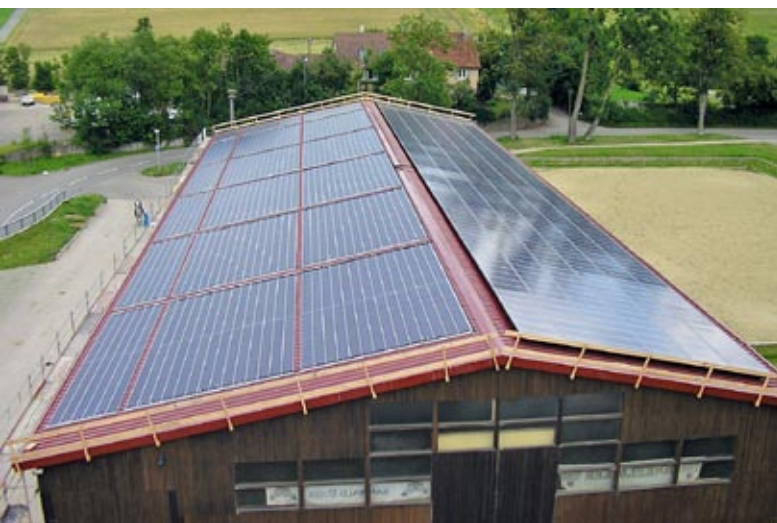
Von der Sonne verwöhnt: das neue Solar-Dach der Reithalle des Reit- u. Fahrvereins Weil der Stadt. Foto: Reit- und Fahrverein
