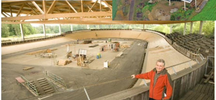
Reiner Dinger, der Gründer des Radsport-Fördervereins Gäufelden, vor „seinem Baby“, der neuen, überdachten Radrennbahn mit der Solaranlage auf dem Dach.
